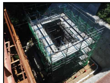
現地の状況 (古市場第2高架橋下部第2工事)
