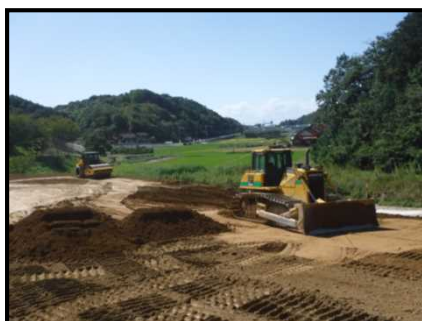
現地の状況 (上古市地区改良外工事)
