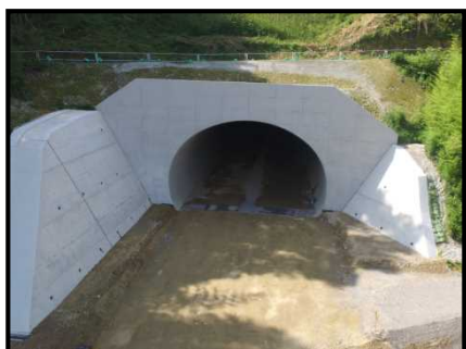
現地の状況 (新木部トンネル（仮称）)
