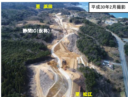
写真① 静間IC(仮称)付近の改良工事の様子
