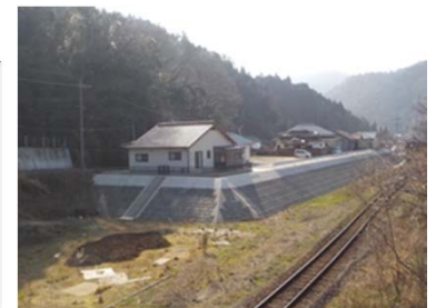
宅地嵩上げ整備箇所(松川橋付近)
