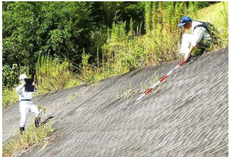
堤防点検状況
