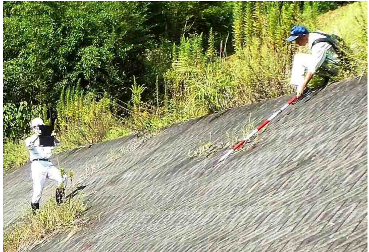
堤防点検状況
