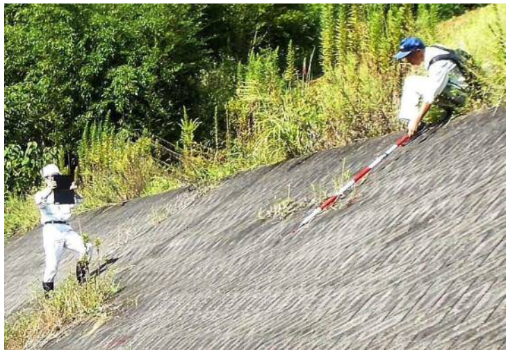
堤防点検状況
