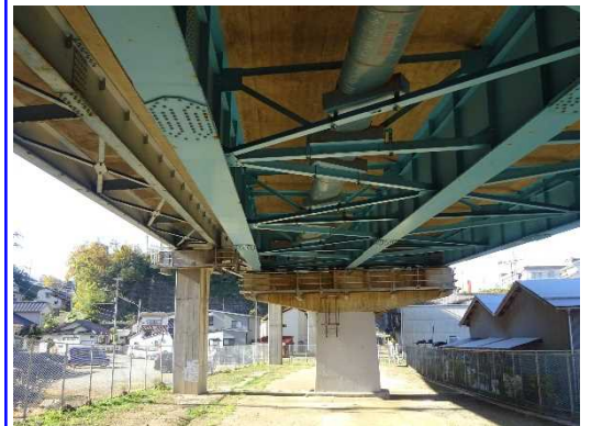
青川陸橋(橋の下)
