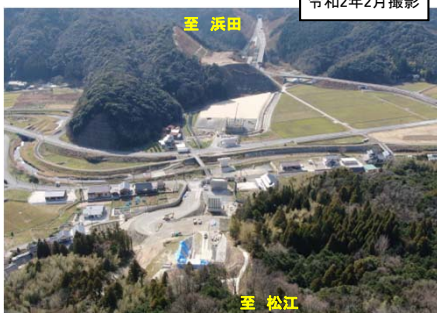
写真③ 静間・仁摩道路 大國高架橋(仮称)付近の工事状況
