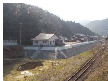
宅地嵩上げ整備箇所(松川橋付近)
