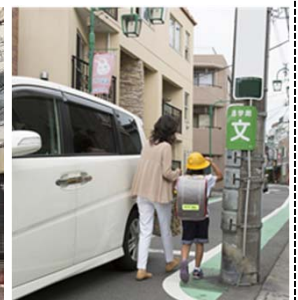
<歩行の支障となる電柱の事例>
