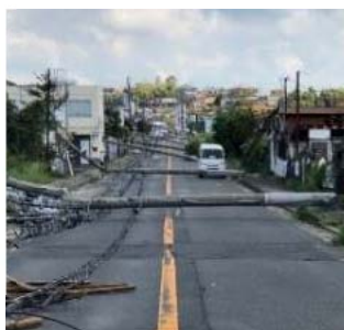
<電柱の倒壊による道路閉塞の事例>
