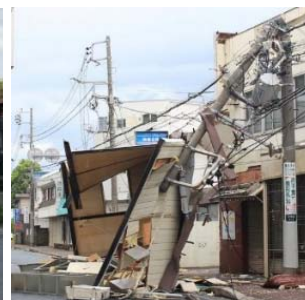
<飛来物による電柱倒壊の事例>
