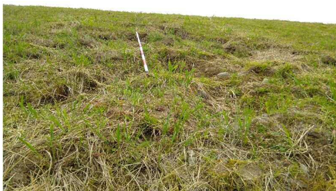
動物等による堤防の掘り返し (江津市桜江町)
