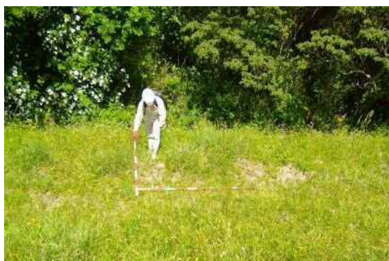
動物等による堤防の掘り返し (益田市金地町)
