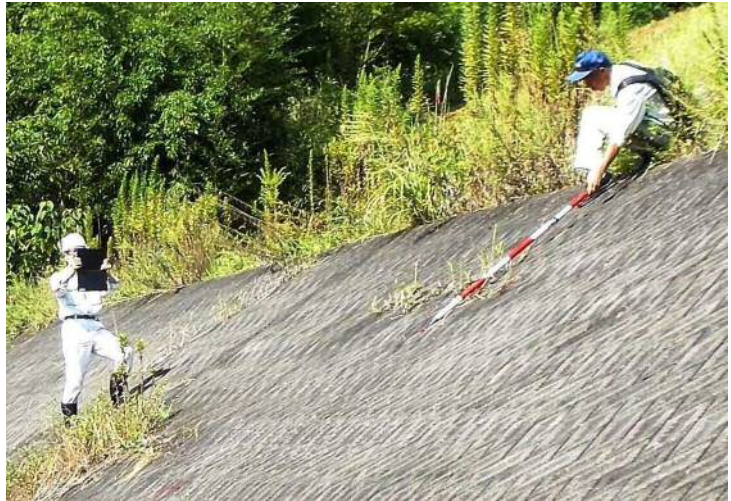
堤防点検状況
