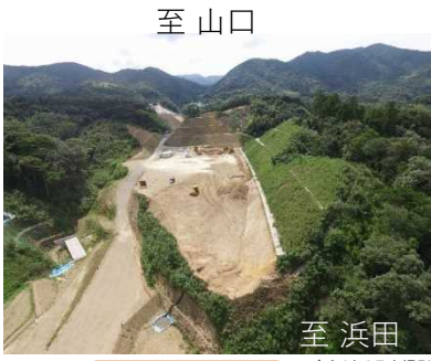
工事現場状況
