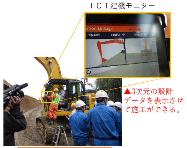
ICT建設機械操作説明
