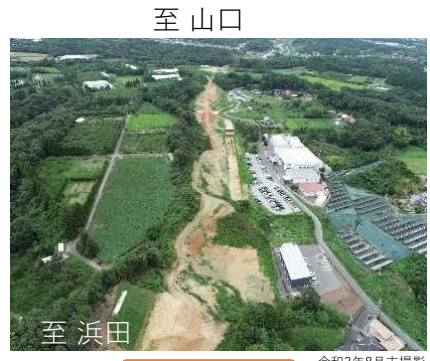
工事現場状況
