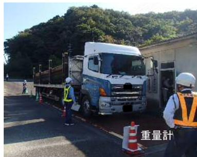
車両重量計測・寸法計測(幅)
