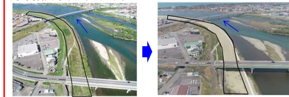
河床掘削事例（高津地区）
