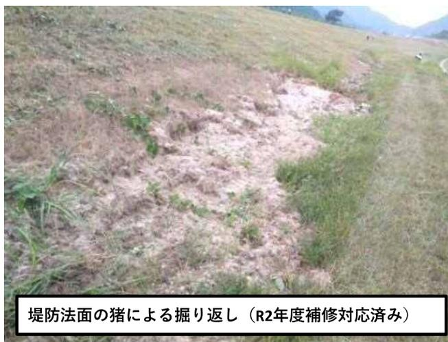
堤防法面の猪による掘り返し(R2年度補修対応済み)
