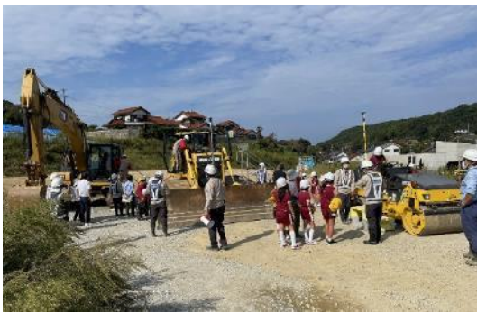
昨年度の実施状況(建設機械の乗車体験) [令和4年10月撮影]
