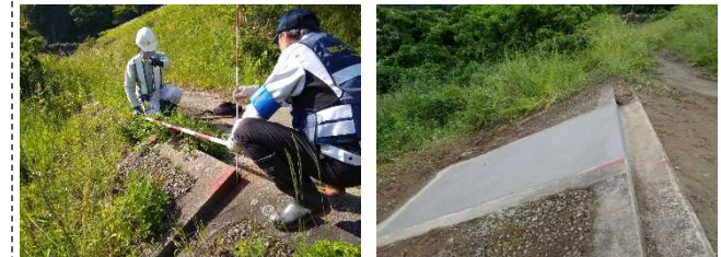
護岸の変状を修繕した例
