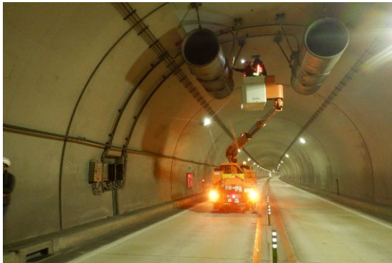
トンネル換気設備
