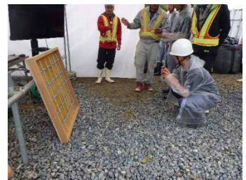
ICT 体験(3D 配筋検査システム)の様子
