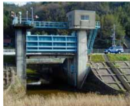
排水門の点検状況
