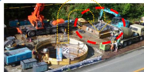
掘削土を穴からの引き上げタンクに貯めてる状況
