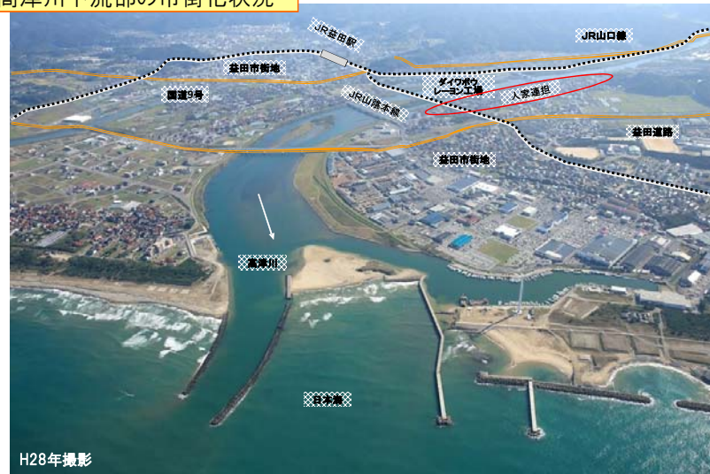
高津川下流部の市街化状況
