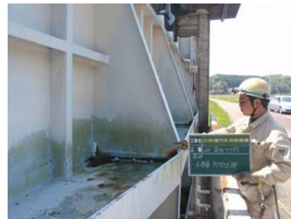
排水門等の点検状況
