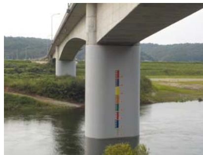
橋梁への量水標の設置
