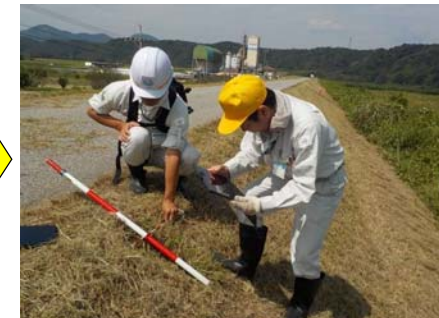
堤防点検状況
