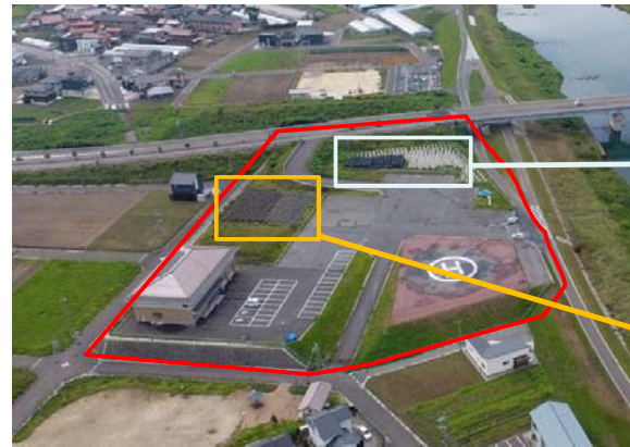
高津川河川防災ステーションの備蓄資材保管状況
