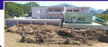
平成28年台風10号により、岩手県の要配慮者利用施設では利用者9名の全員が死亡。
