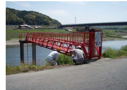
許可工作物の点検状況
