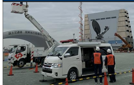
国土交通省地方整備局 (車載型基地局設営)
