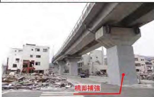
**【耐震補強済み(鋼板巻立補強)】**
