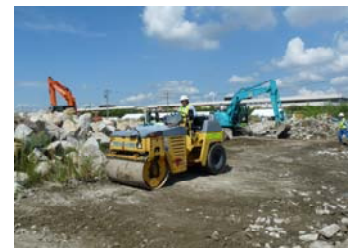
道路啓開作業
