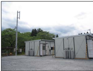
仮設住宅にてエリア改善している様子 ※陸前高田市下矢作小学校
