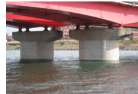
橋脚巻立て（対策後）
