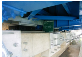
落橋防止装置（対策後）
