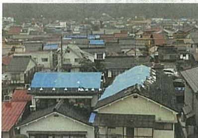
屋根被災状況全景
