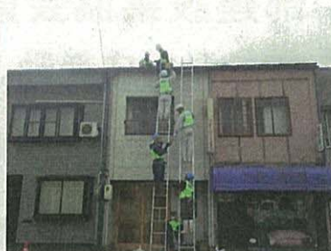
屋根シート掛け状況
