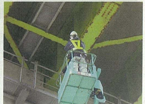
国道9号橋梁点検状況(東伯郡湯梨浜町)
