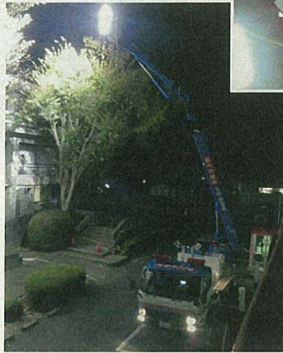
市役所の損傷箇所を監視するための 照明車【カメラ付】(倉吉市)
