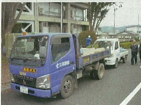
資機材運搬状況(倉吉市)
