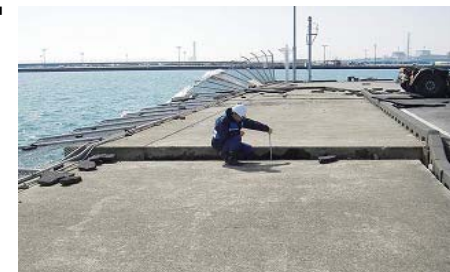
岸壁の点検状況
