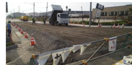
臨港道路の応急復旧工事
