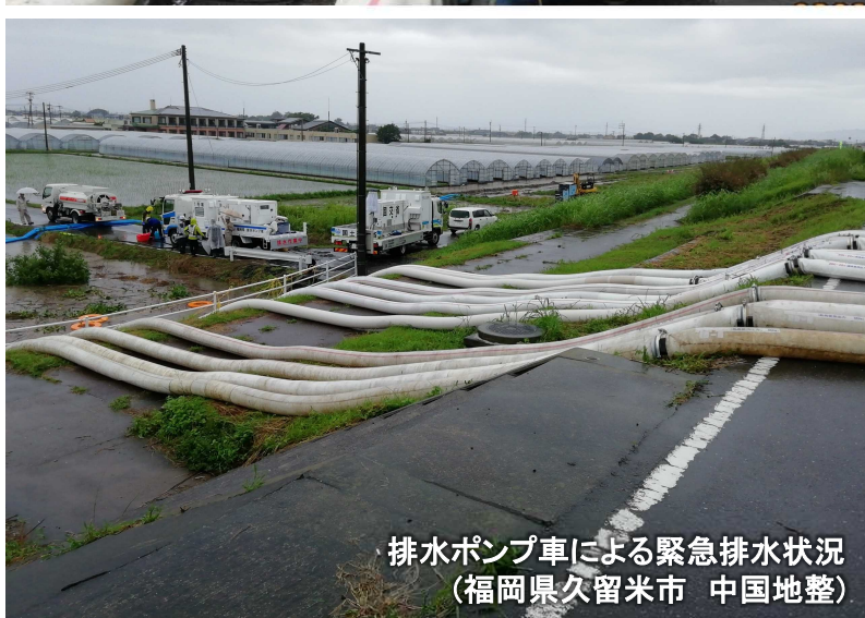
協力企業と連携し排水作業を実施 (福岡県久留米市 四国地整)
