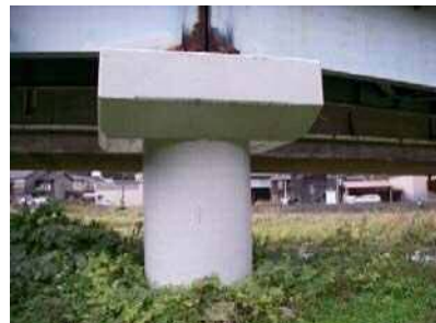
対策後(修繕実施)
