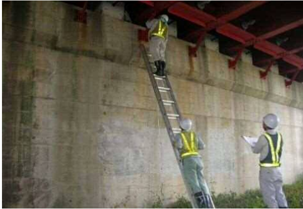
(梯子による定期点検)
