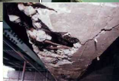
国道188号 新寿橋(山口県岩国市川下町) ・1953年建設 (コンクリート橋+鋼橋) ・主桁、下部工の損傷が激しいため、 2007年架替 (経年数54年)
