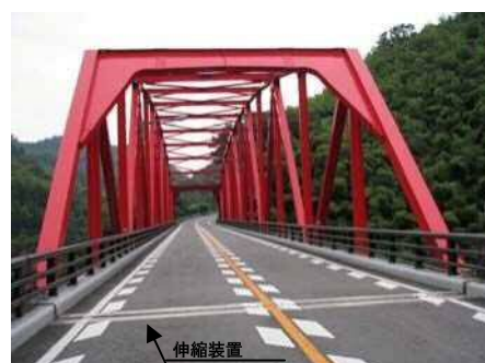
国道9号 東津和野大橋
