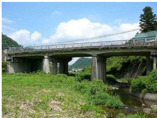
国道53号 白石橋(岡山市建部町) (1936年完成 供用年数81年)
