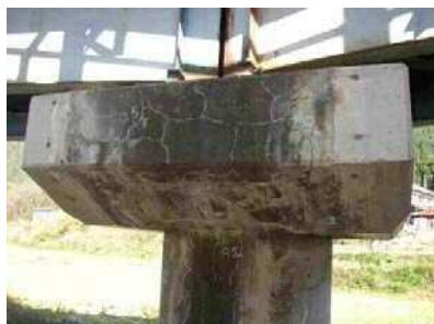
対策前(建設後28年経過)
