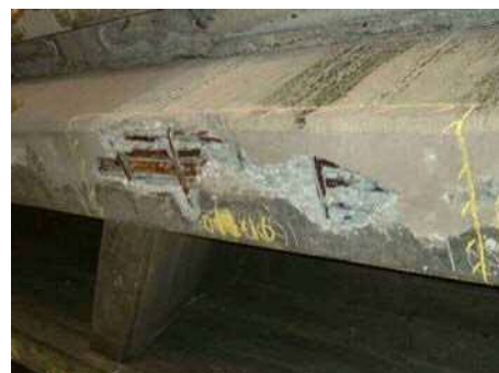
中酸化及び経年劣化により、主桁に発生した剥離・鉄筋露出
