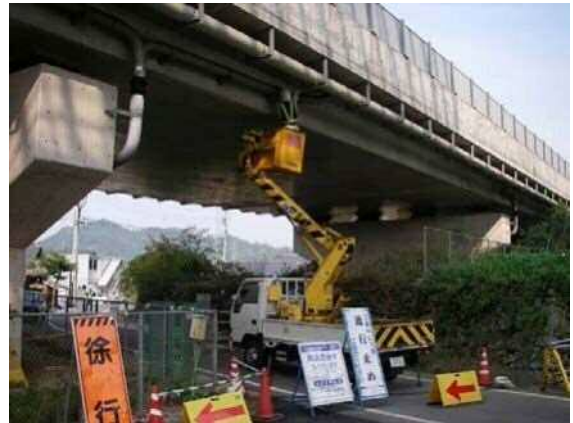
(高所作業車による定期点検)
