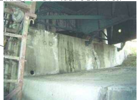
アルカリ骨材反応によるひびわれ
