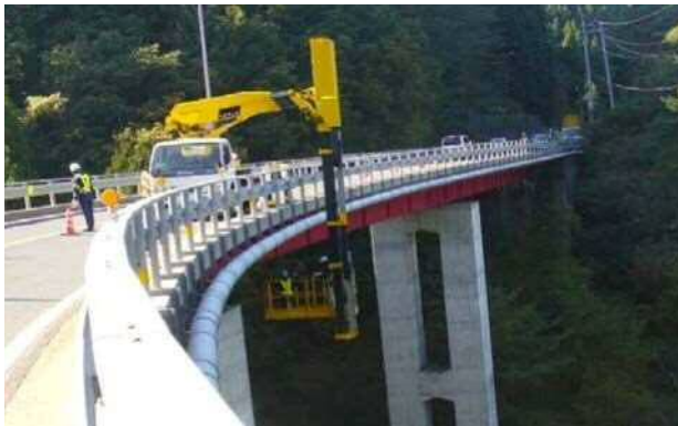
(橋梁点検車による定期点検)
