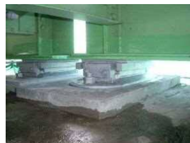
対策後(修繕実施)
