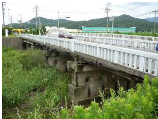
国道191号 葉中橋(山口県下関市豊浦町) (1932年完成 供用年数85年)
