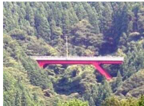
国道53号 杉見橋
