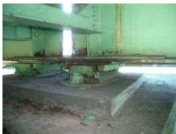
対策前(建設後37年経過)
