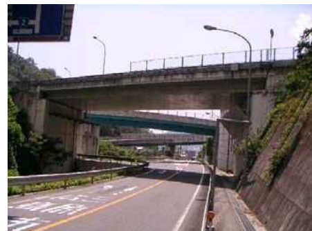
国道2号 恵下谷橋
