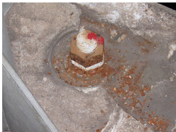
⑥支柱基部のボルトの腐食
