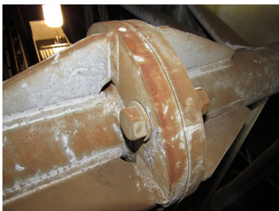
⑥支柱基部のボルトの腐食
