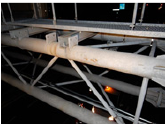
⑤支柱基部の腐食
