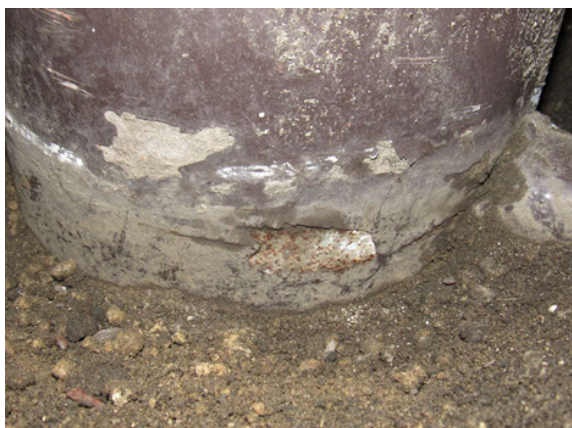
⑤支柱基部の腐食
