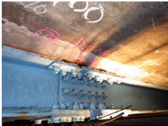
⑥排水樋部の腐食
