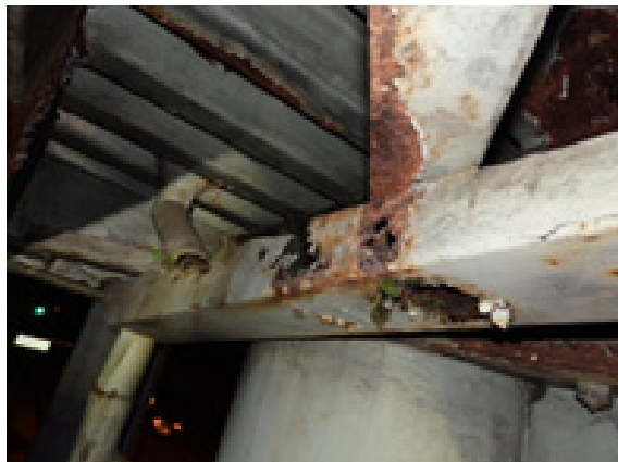
⑥排水樋部の腐食
