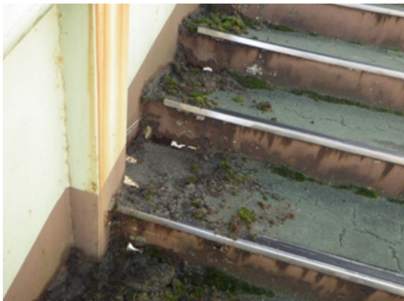
⑤階段蹴上げ部の腐食
