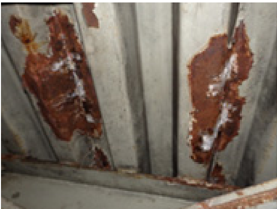
⑤階段蹴上げ部の腐食
