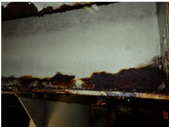
③床版部デッキプレートの腐食
