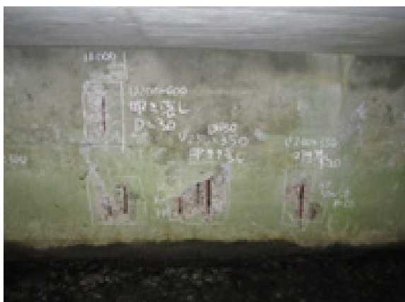
①側壁部のうき、はく離(鉄筋露出)
