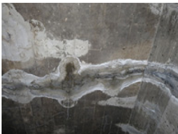
②頂版部のひび割れと漏水
