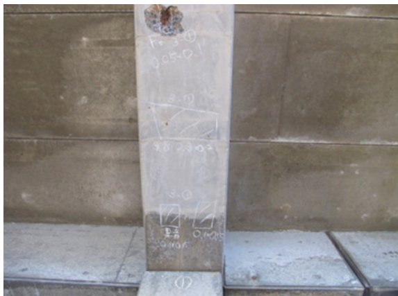
③横梁部のうき、はく離(鉄筋露出)
