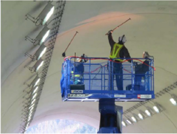
覆工コンクリート点検状況
