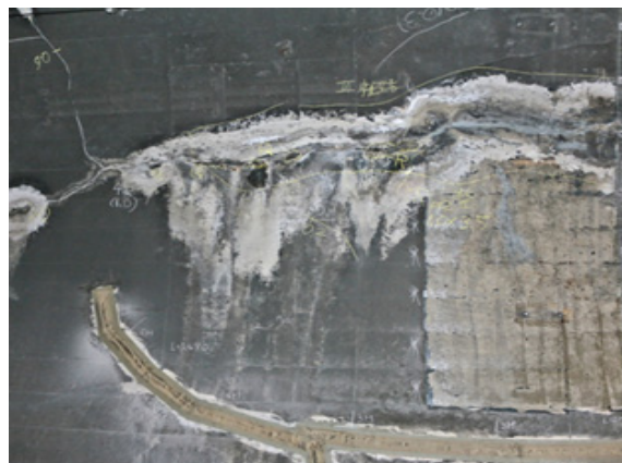
ひび割れ沿いのうき
