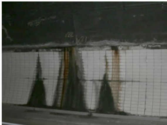
水平打継目部からの漏水
