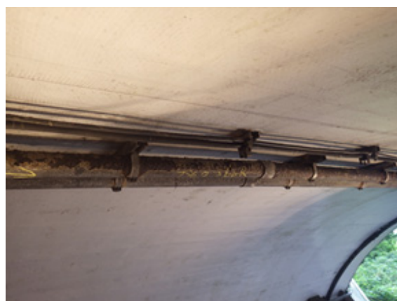
ケーブル保護管腐食
