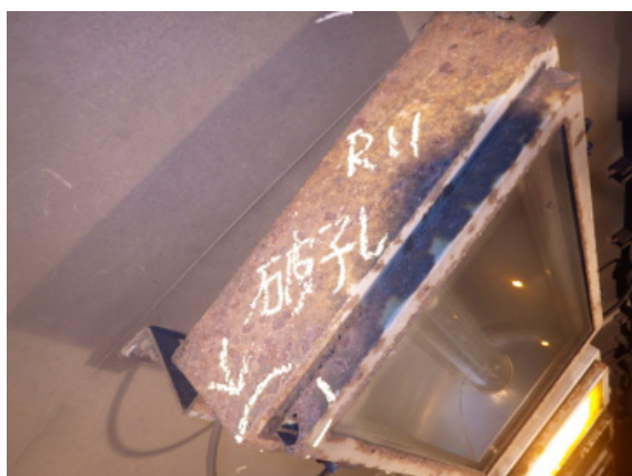
照明器具の腐食
