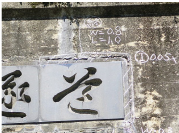
トンネル名板周辺部のうき
