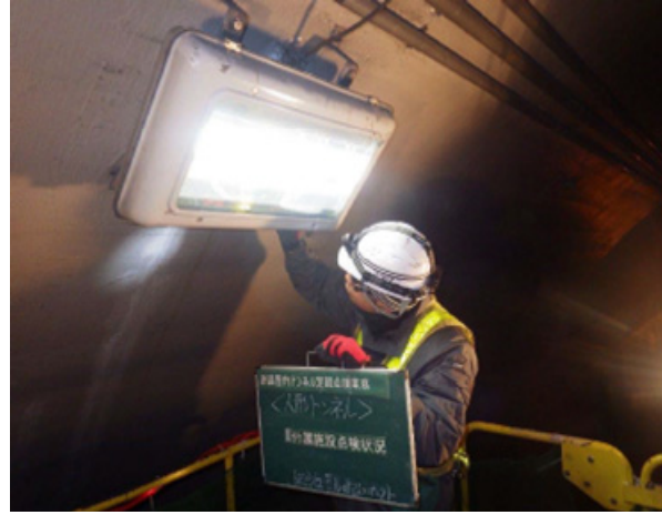
附属物点検状況
