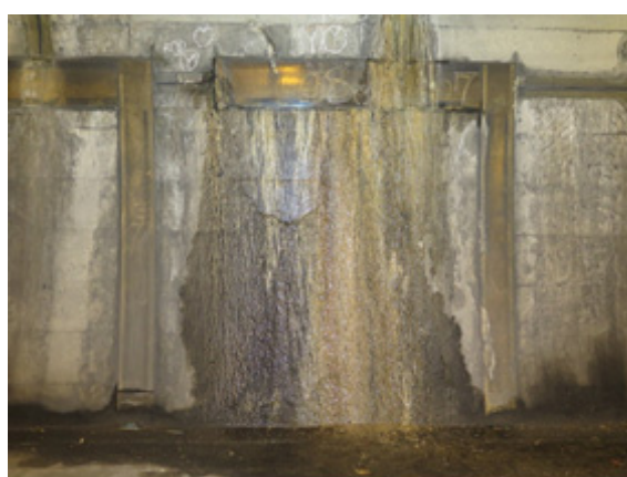
水平打継目部からの漏水
