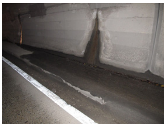
漏水による路面滞水
