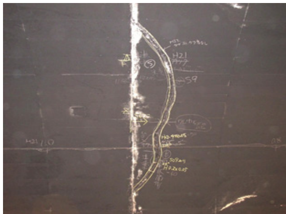
横断目地部に閉合するひび割れ
