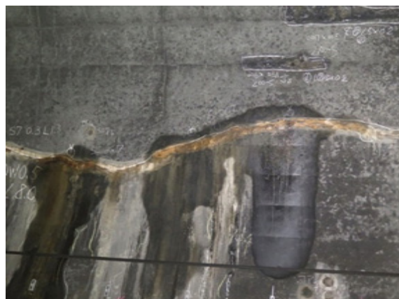
漏水を伴ったひび割れ
