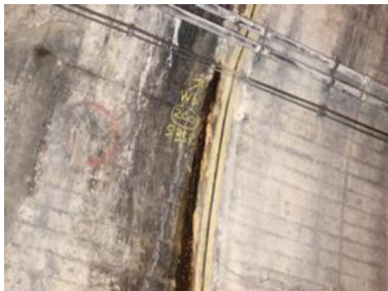
横断目地部付近からの漏水
