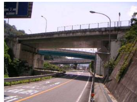
国道2号 恵下谷橋
