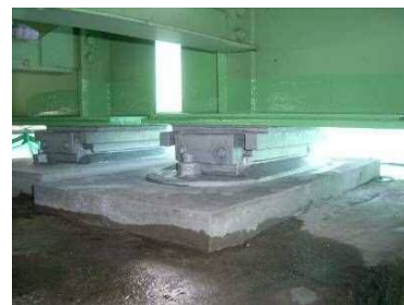
対策後(修繕実施)
