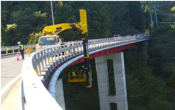
(橋梁点検車による定期点検)
