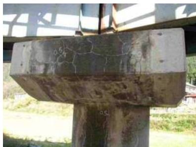
対策前(建設後28年経過)
