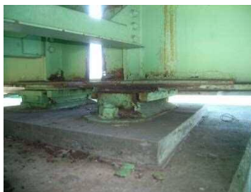
対策前(建設後37年経過)
