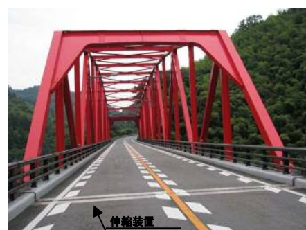
国道9号 東津和野大橋
