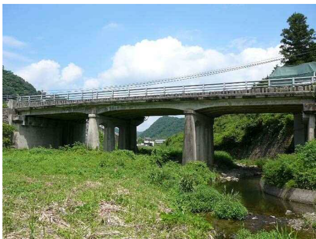
国道53号 白石橋(岡山市建部町) (1936年完成 供用年数82年)
