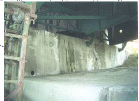
アルカリ骨材反応によるひびわれ
