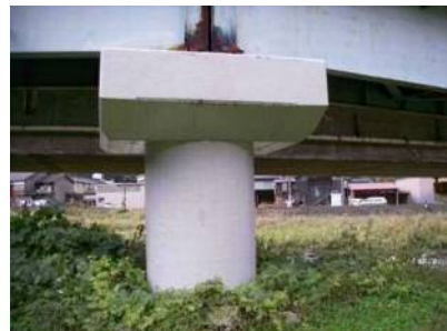
対策後(修繕実施)
