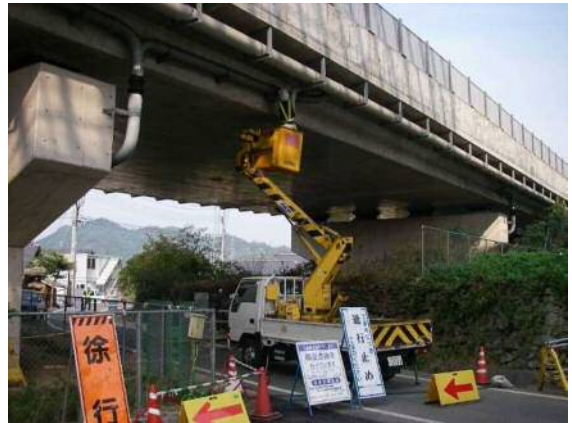
(高所作業車による定期点検)
