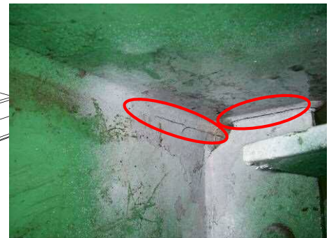
交通荷重により主桁に発生した疲労亀裂
