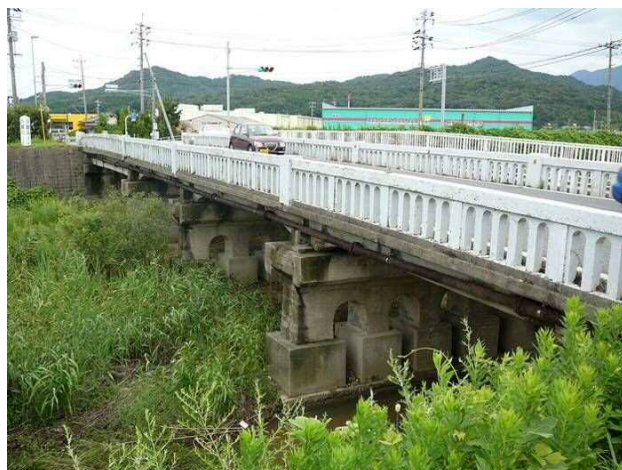
国道191号 葉中橋(山口県下関市豊浦町) (1932年完成 供用年数86年)
