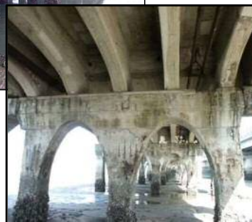
国道190号 厚東川大橋(山口県宇部市藤曲) ・1935年建設 (コンクリート橋) ・塩害による主桁、下部工の損傷が激しいため、 1997年架替 (経年数62年)
