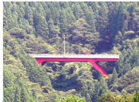
国道53号 杉見橋
