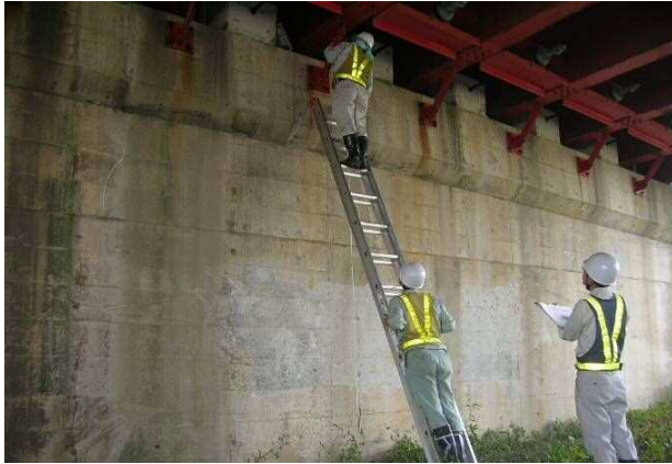
(梯子による定期点検)
