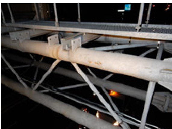
⑤支柱基部の腐食
