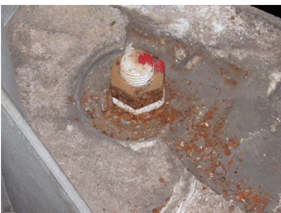
⑥支柱基部のボルトの腐食
