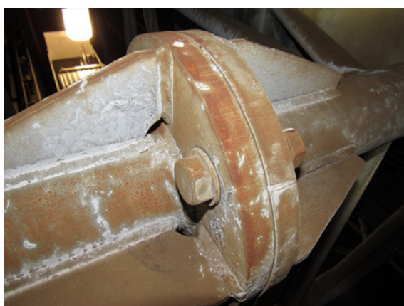
⑥支柱基部のボルトの腐食
