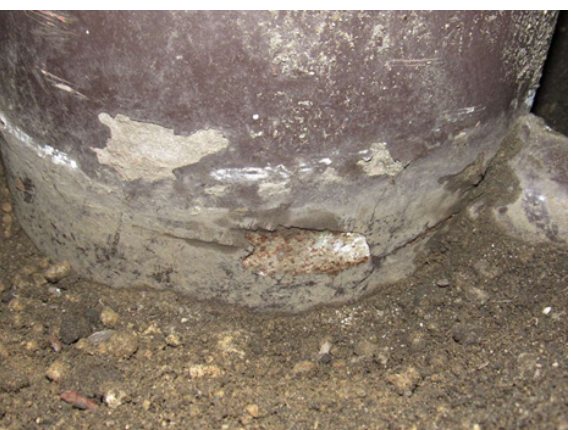
⑤支柱基部の腐食
