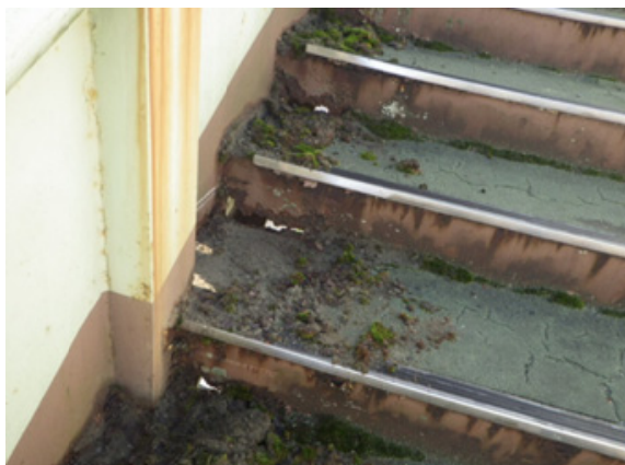
⑤階段蹴上げ部の腐食
