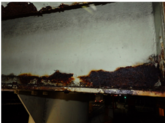
③床版部デッキプレートの腐食
