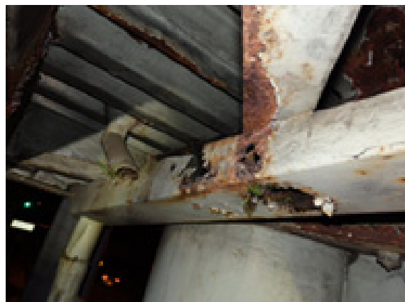
⑥排水樋部の腐食
