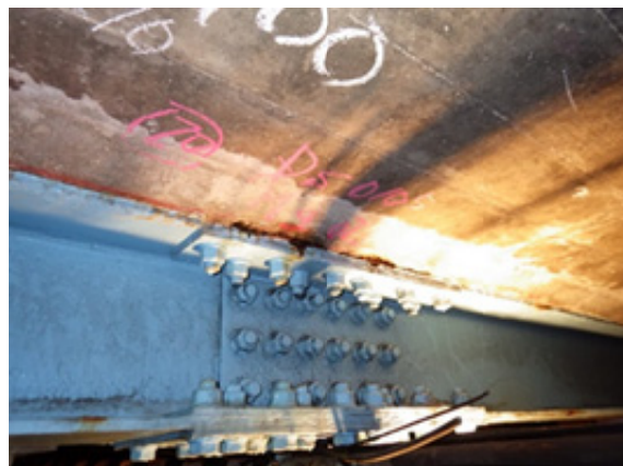
⑥排水樋部の腐食
