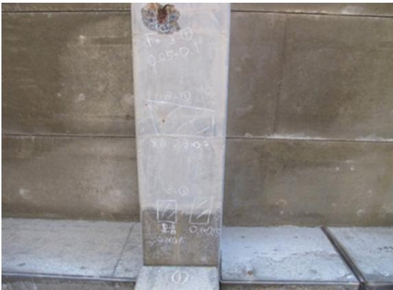
②柱部のうき、はく離(鉄筋露出)
