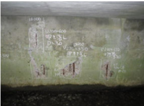
②頂版部のひび割れと漏水
