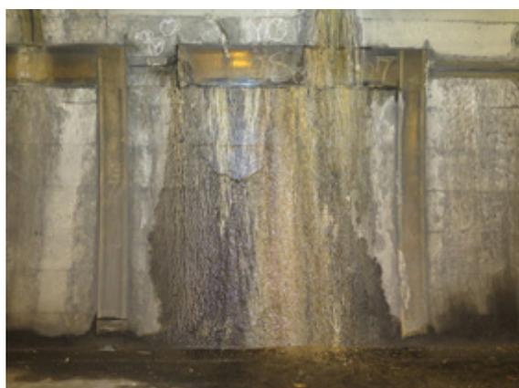
水平打継目部からの漏水
