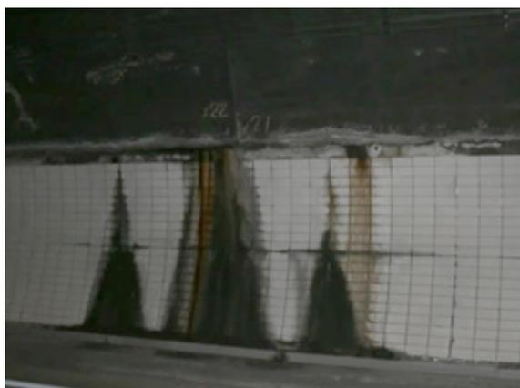
水平打継目部からの漏水
