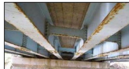
鋼材の腐食
