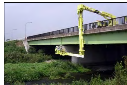
橋梁点検車による 定期点検
