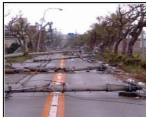
(台風による道路の被災状況)
