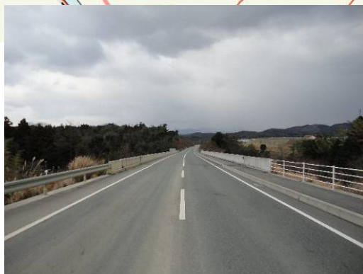
写真1 県道浅利渡津線 (供用済区間)
