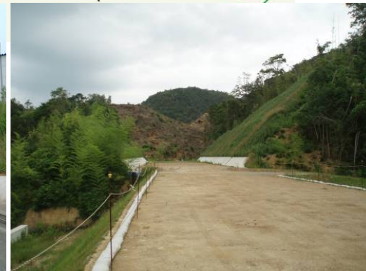
写真3 県道浅利渡津線 (事業中区間)
