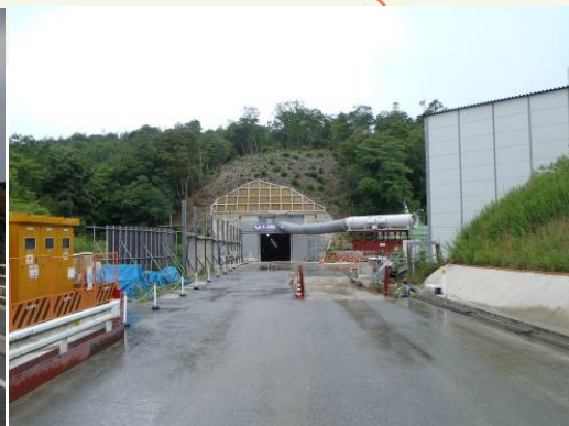
写真2 県道浅利渡津線 (事業中区間)
