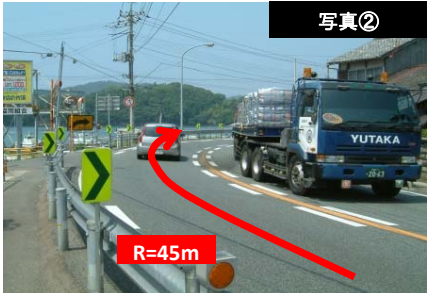
▲線形不良箇所の状況
