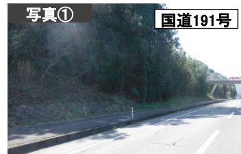
▲土砂災害危険箇所 (長門市三隅下)
