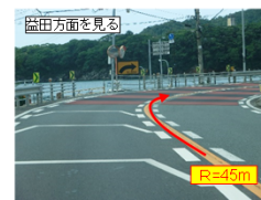
▲平面線形不良箇所
