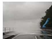
▲越波の発生状況
