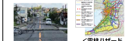
＜電柱倒壊による道路閉塞＞
