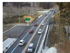
津波による被害がなかった三陸縦貫自動車道
