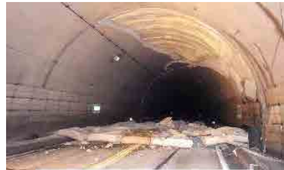
断層変位による損傷状況
