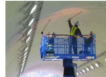
トンネル定期点検
