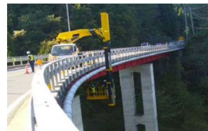
橋梁定期点検
