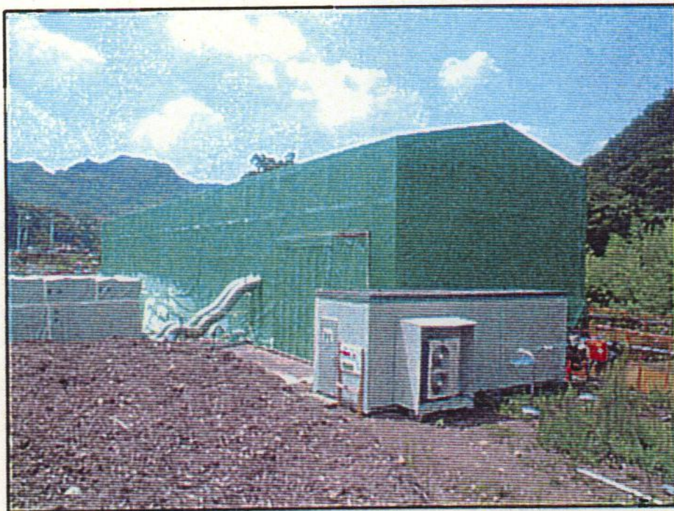
防塵建屋の状況
