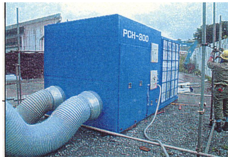
集塵機及び排気設備
