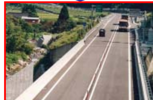
交通機能の確保 (供用区間)
